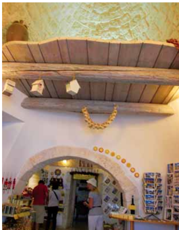
Nad čiastočným dreveným stropom je pôvodná kamenná kužeľová klenba.
