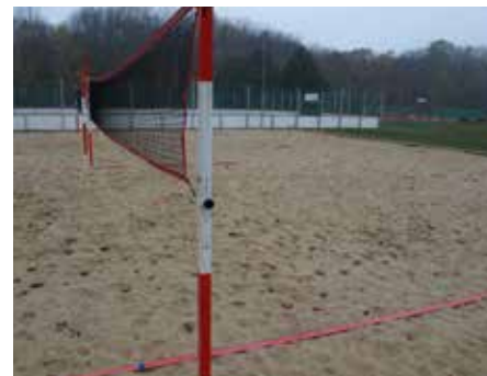
Z kremenného piesku vytvoriť rovný kompaktný povrch nemožno. Súvisí to s tým, že na rozdiel od častíc antuky sú častice piesku nepórovité, majú hladký povrch a sú aj v priemere väčšie.
