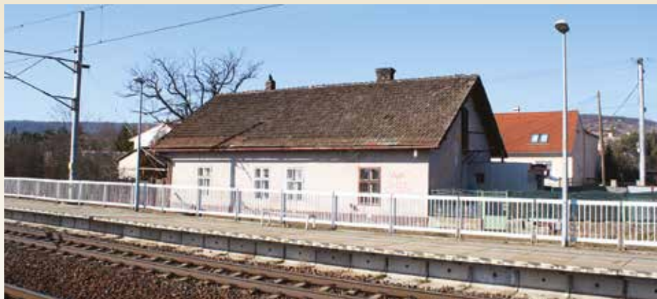
Pôvodná budova stanice prvého úseku konskej železnice z roku 1840 vo Sv. Jure
